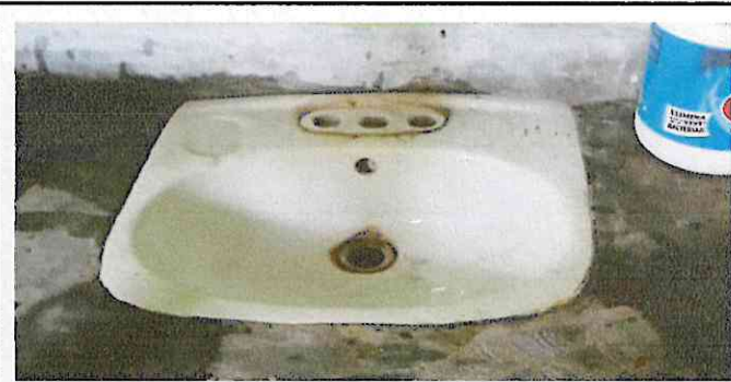
Sustitución de lavamanos.
