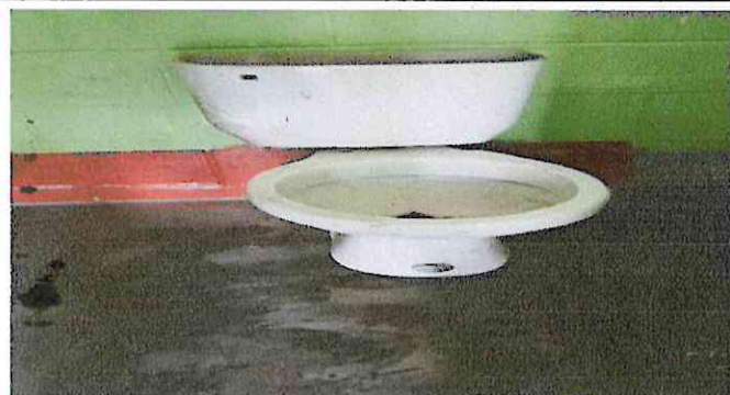
Sustitución y reparación de servicios sanitarios.
