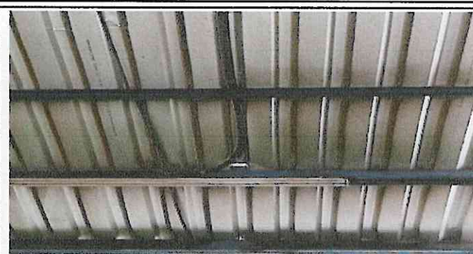
Sustitución y mantenimiento de soporte de metal y pintura.
