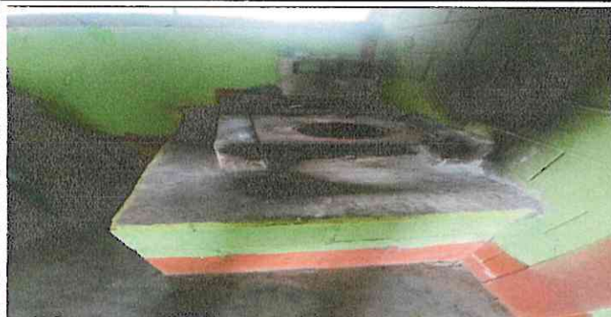
Sustitución de plancha, implementación de azulejo, sustitución de pila, mueble de concreto, chimenea de tubo de concreto.
