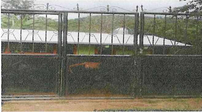
Mantenimiento de portón de metal (lijado y pintura)
