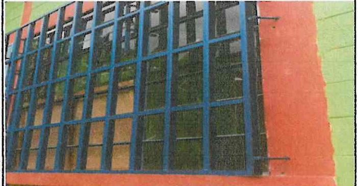
Sustitución de balcones
